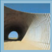
Condotte in acciaio ondulato e zincato
